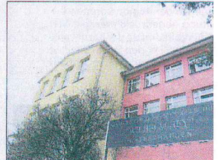
Die Grund- und Regelschule Wilhelm Hey strahlt in frischen Farben. Im Inneren der müsste aber einiges saniert werden.
