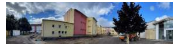
(Baustelle Schulhof im August 2021)
